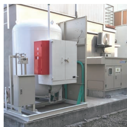
災害バルク貯槽と非常用発電機
