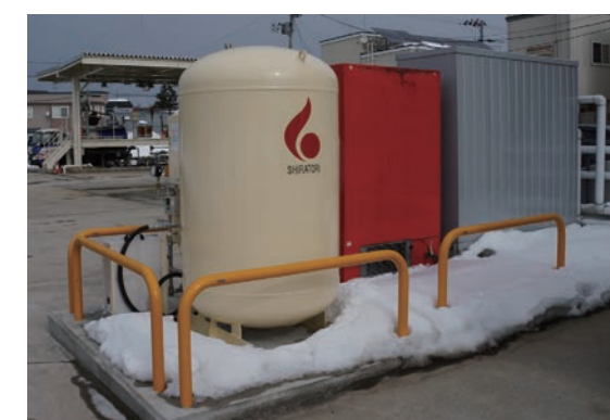
災害バルク貯槽
