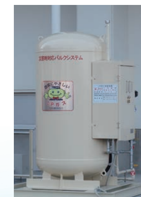
災害バルク貯槽
