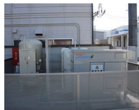
災害バルク貯槽と非常用発電機
