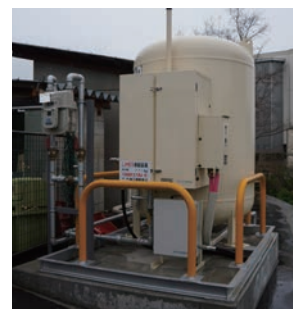
災害バルク貯槽
