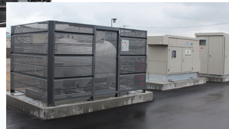
災害バルク貯槽と非常用発電機
