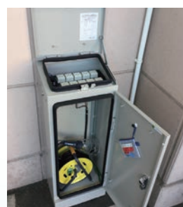
非常用コンセントボックス
