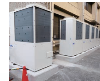
電源自立型 GHP (中央公民館)
