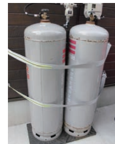
LPガスの軒下在庫
