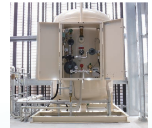
災害バルク貯槽
