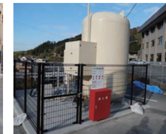
災害バルク貯槽 (本庁舎と中央公民館)
