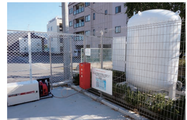
災害バルク貯槽と接続した可搬式発電機
