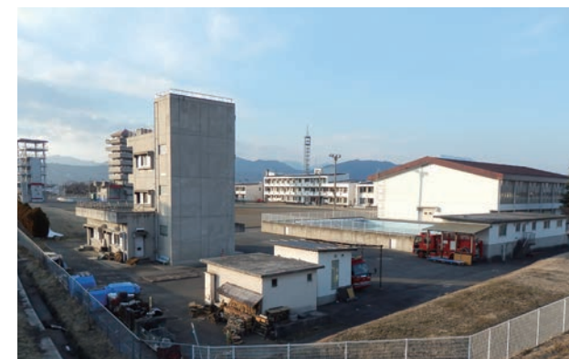
長野県消防学校
