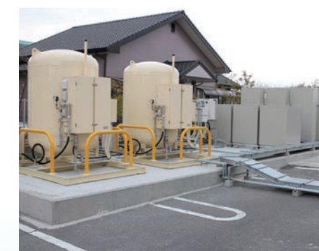
災害バルク貯槽と非常用発電機
